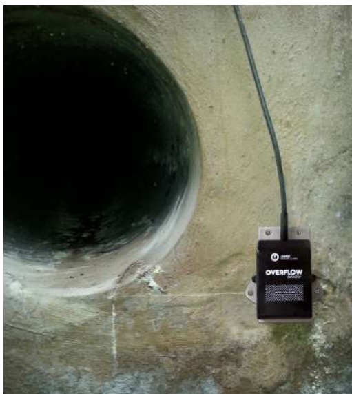
Installation en déversoir d'orage
