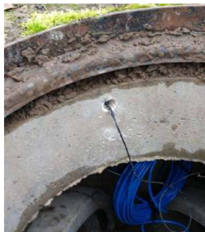
Insertion de l'antenne sous la semelle
