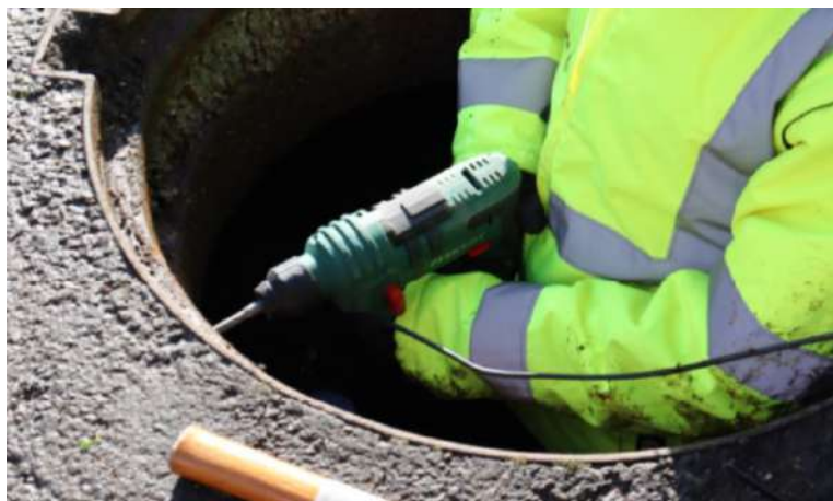
Perçage dans le regard
