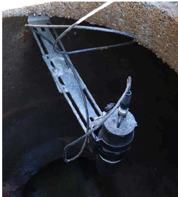
Exemple d'Installation avec 2 plaques de montage
