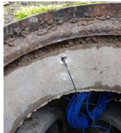
Insertion de l'antenne sous la semelle
