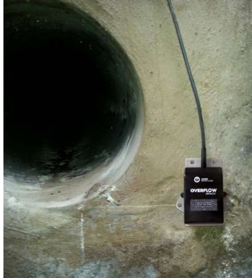
Installation en déversoir d'orage
