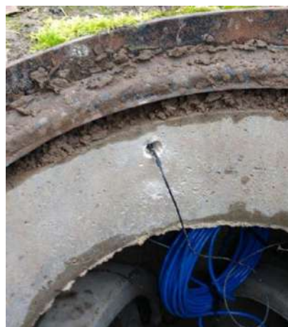
Insertion de l'antenne sous la semelle
