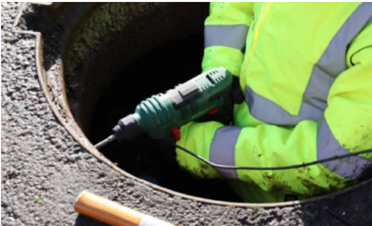
Perçage dans le regard
