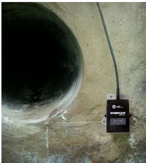
Installation en déversoir d'orage
