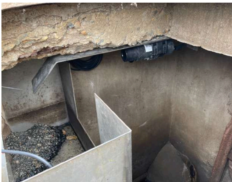
Installation avec kit de fixation à renvoi d'angle
