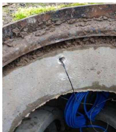
Insertion de l'antenne sous la semelle
