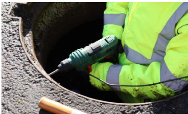
Perçage dans le regard
