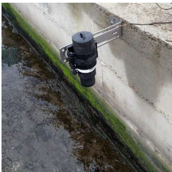
Exemple d'installation avec une plaque de montage
