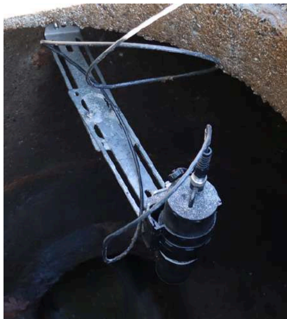
Exemple d'Installation avec 2 plaques de montage
