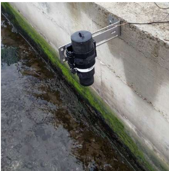
Exemple d'installation avec une plaque de montage
