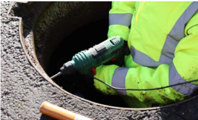
Perçage dans le regard
