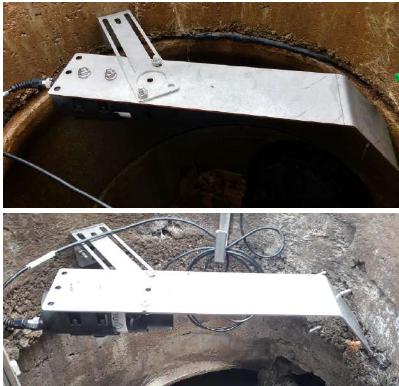
Installation avec kit de fixation à renvoi d'angle
