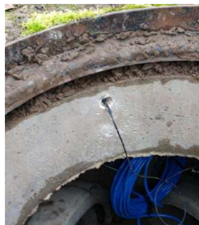
Insertion de l'antenne sous la semelle
