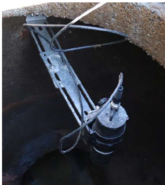
Exemple d'installation avec 2 plaques de montage
