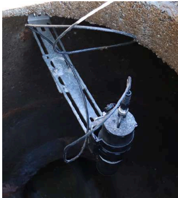
Exemple d'installation avec 2 plaques de montage
