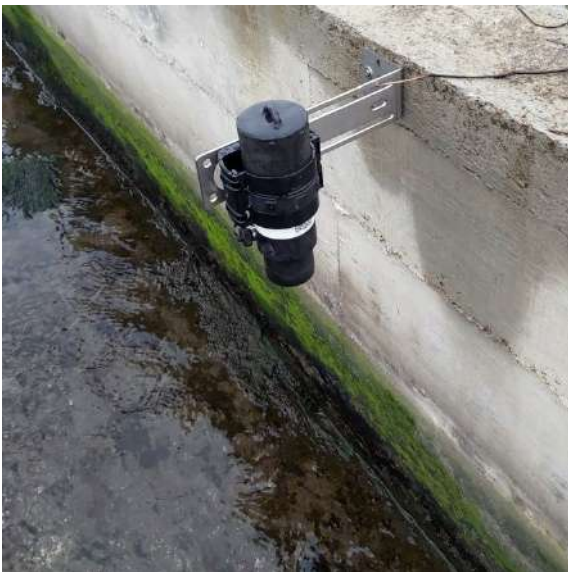
Exemple d'installation avec une plaque de montage
