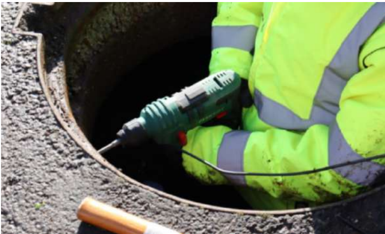
Perçage dans le regard
