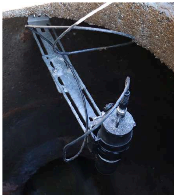
Exemple d'installation avec 2 plaques de montage
