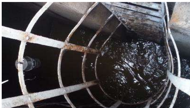
Suspendu à un barreau d'échelle
