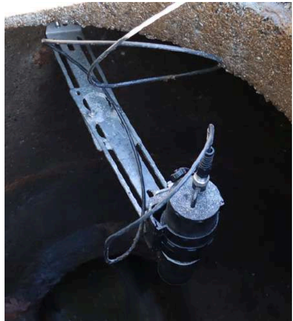
Exemple d'installation avec 2 plaques de montage
