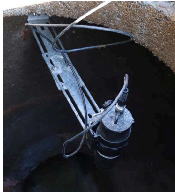
Exemple d'installation avec 2 plaques de montage
