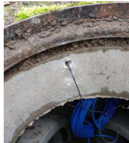
Insertion de l'antenne sous la semelle
