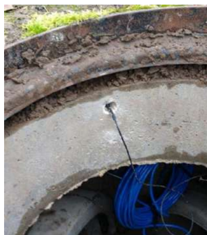
Insertion de l'antenne sous la semelle
