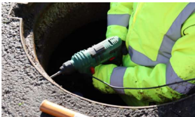
Perçage dans le regard
