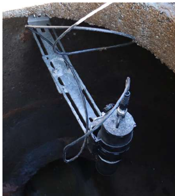
Exemple d'installation avec 2 plaques de montage
