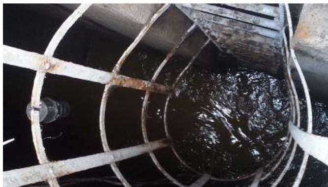
Suspendu à un barreau d'échelle
