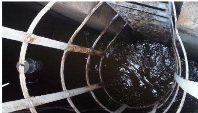
Suspendu à un barreau d'échelle
