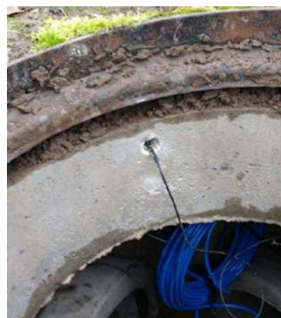
Insertion de l'antenne sous la semelle
