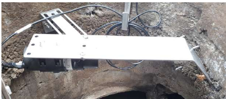
Installation avec kit de fixation à renvoi d'angle
