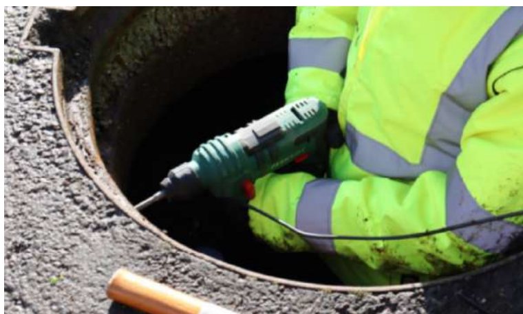
Perçage dans le regard
