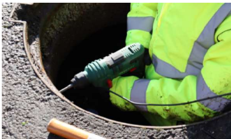
Perçage dans le regard
