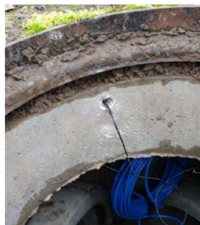
Insertion de l'antenne sous la semelle
