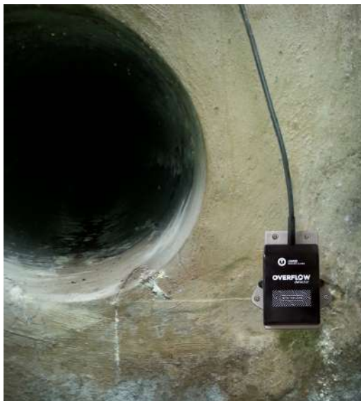
Installation en déversoir d'orage
