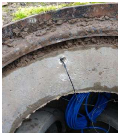
Insertion de l'antenne sous la semelle
