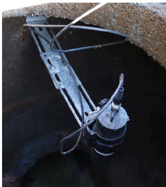
Exemple d'installation avec 2 plaques de montage
