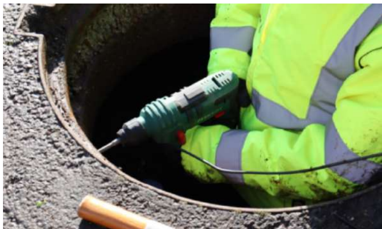
Perçage dans le regard
