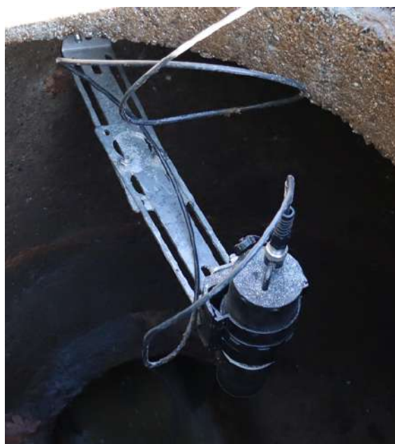
Exemple d'installation avec 2 plaques de montage
