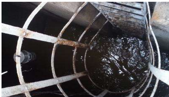
Suspendu à un barreau d'échelle
