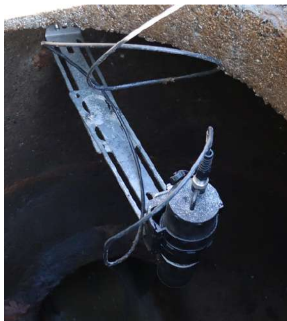
Exemple d'installation avec 2 plaques de montage
