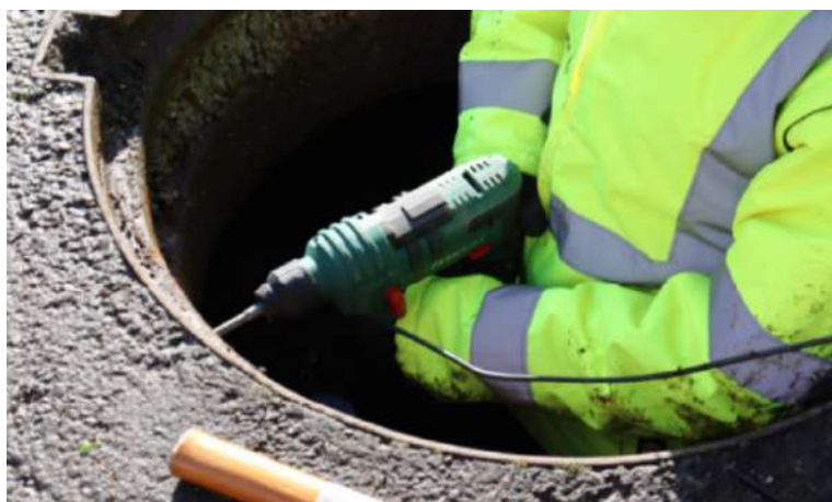
Perçage dans le regard
