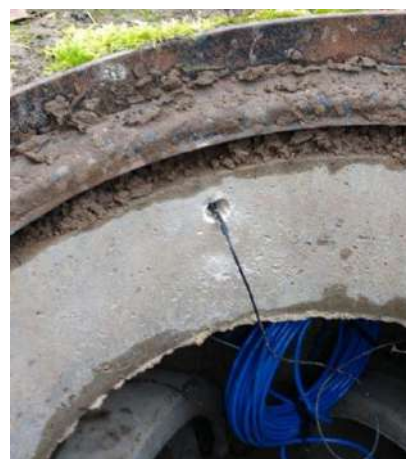
Insertion de l'antenne sous la semelle
