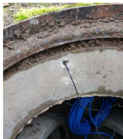
Insertion de l'antenne sous la semelle
