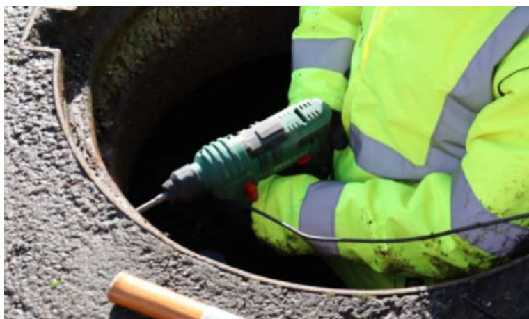
Perçage dans le regard
