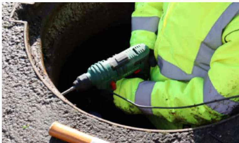
Perçage dans le regard
