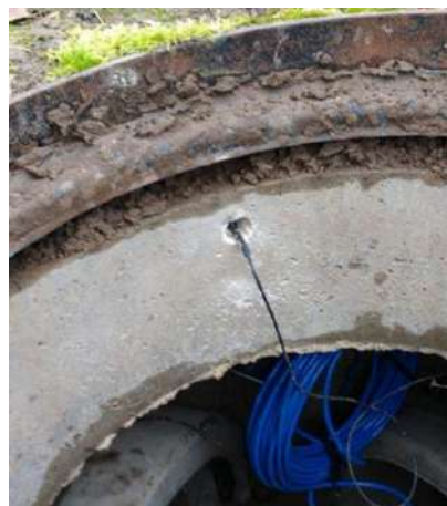
Insertion de l'antenne sous la semelle
